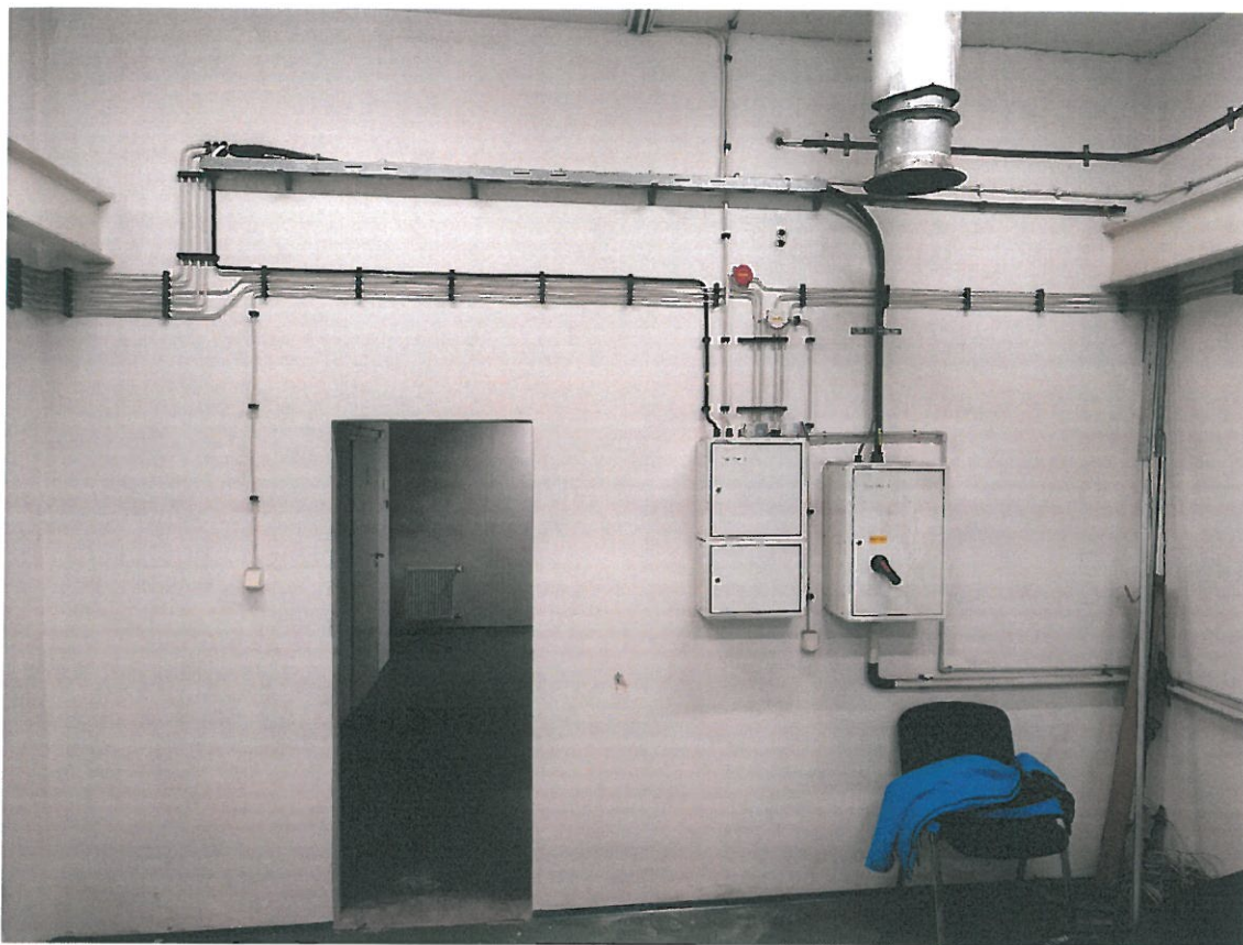
Fot. 5. Ściana Sc.4
