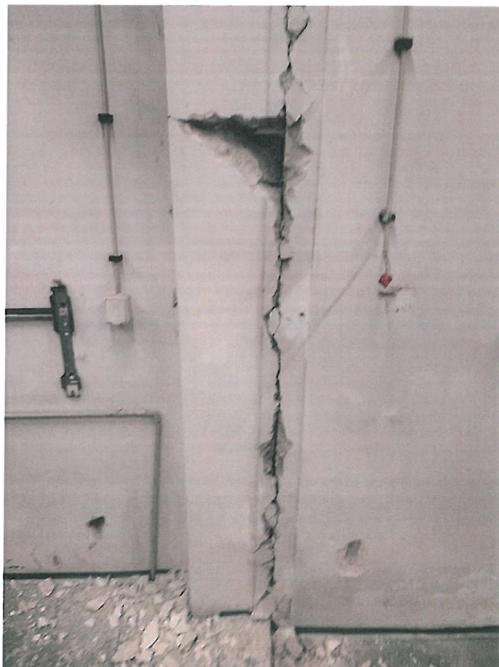
Fot. 8. Odkrywka w rejonie dylatacji pomiędzy ścianą Sc.2 i Sc.5
