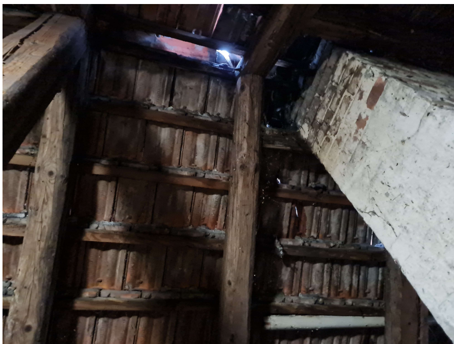
Fot. 2 Nieszczelności pokrycia i zawilgocenie komina
