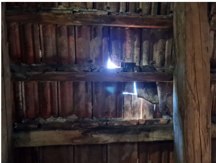
Fot. 4 Nieszczelności pokrycia
