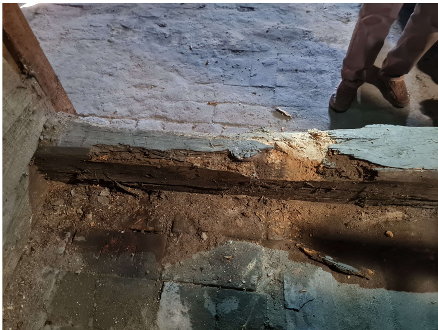
Fot. 1 Korozja tramu drewnianego
