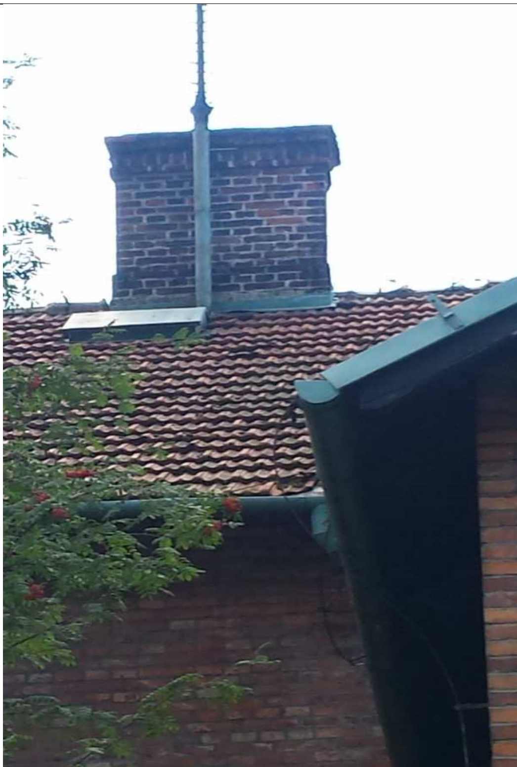
Fot.3 – Zły stan techniczny pokrycia dachu z dachówki ceramicznej, zakładkowej, kwalifikujący się do wymiany
