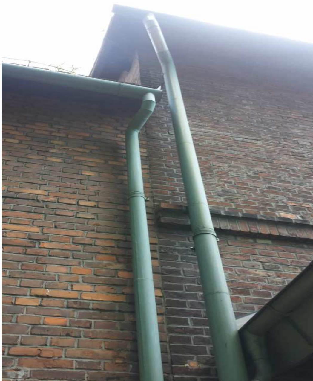
Fot.4 – Elementy odprowadzające wody opadowe z dachu, rynny i rury spustowe z blachy ocynkowanej
