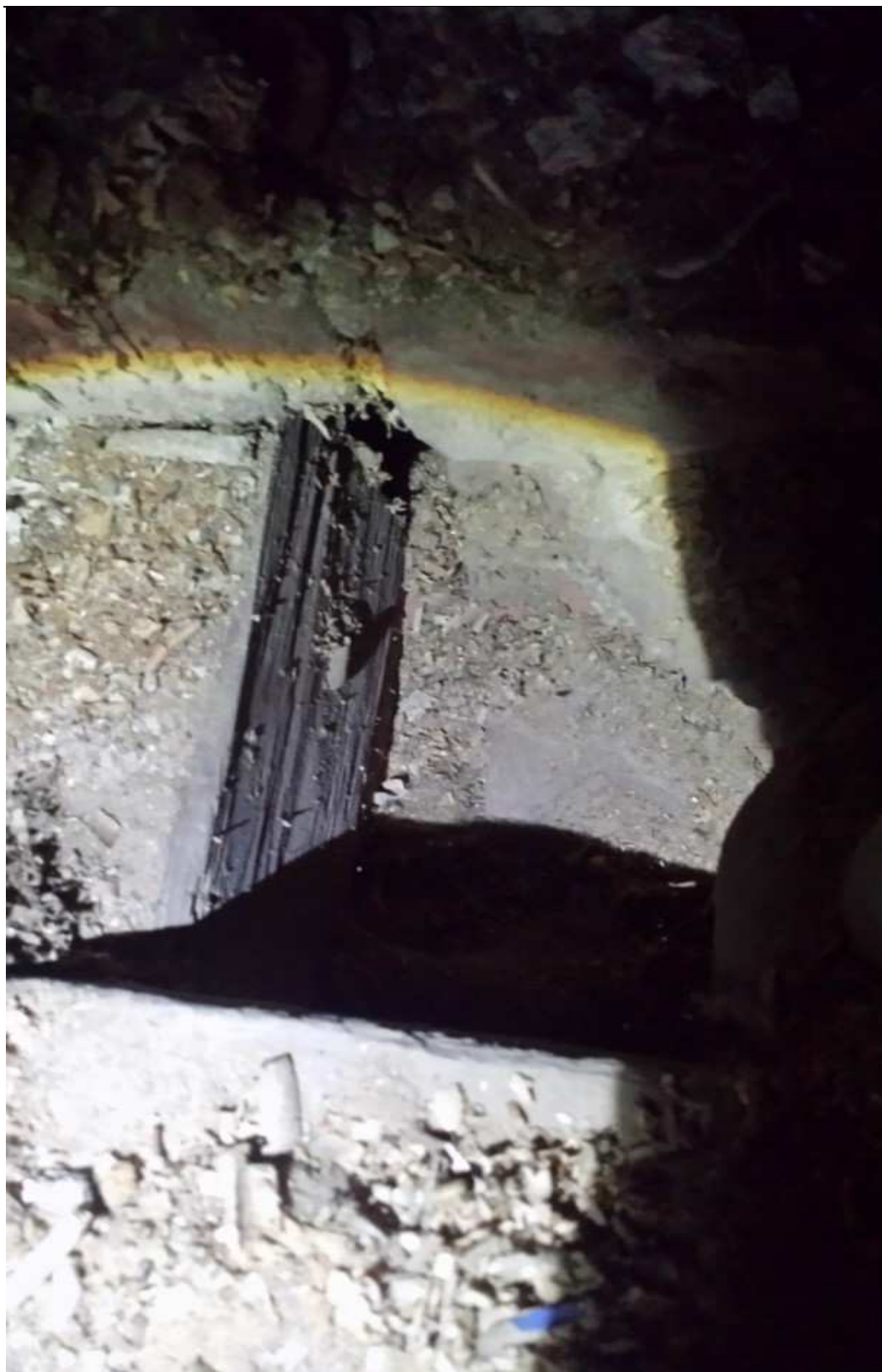
Fot.11 – Strop podstrychowy, wykonana odkrywka drewnianej belki stropowej
