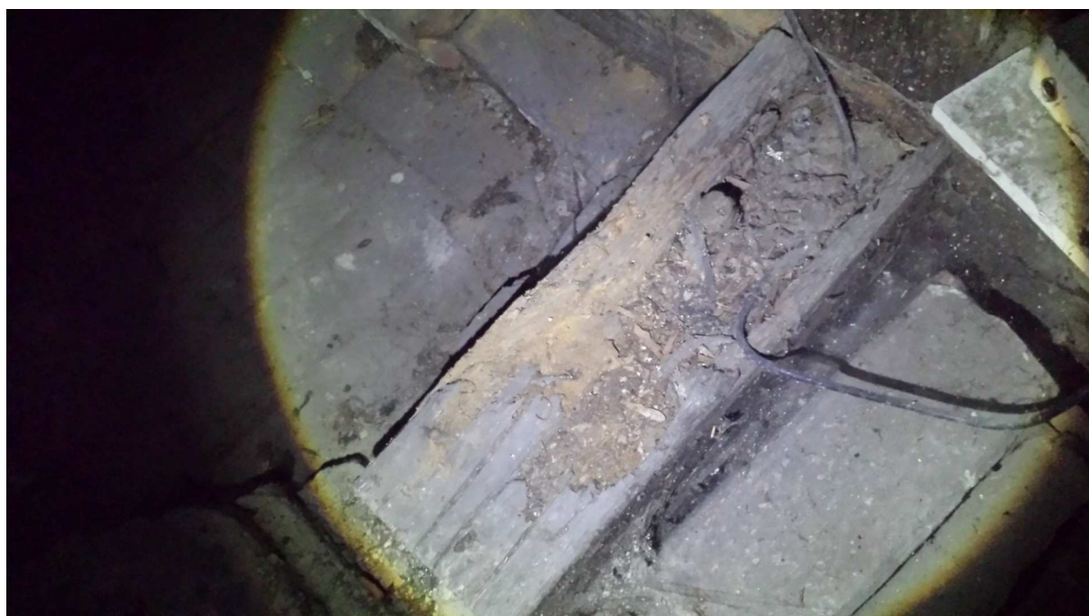
Fot.7,8 – Ślady korozji biologicznej na elementach konstrukcyjnych więźby dachowej
